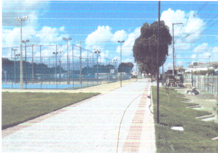
POSTES METÁLICOS COM 2 PÉTALAS (LUMINÁRIAS) E DE CONCRETO COM LUMINÁRIAS
