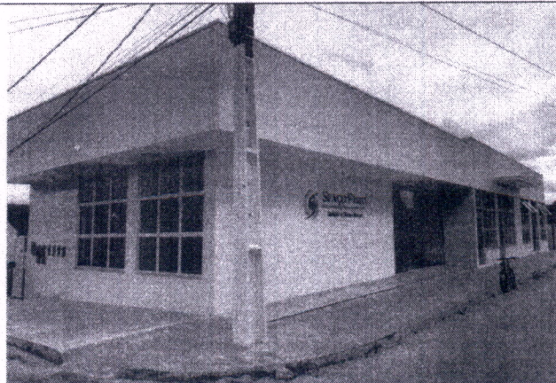
Descrição: EXECUÇÃO FACHADA CONFORME PROJETO E PLANILHA
