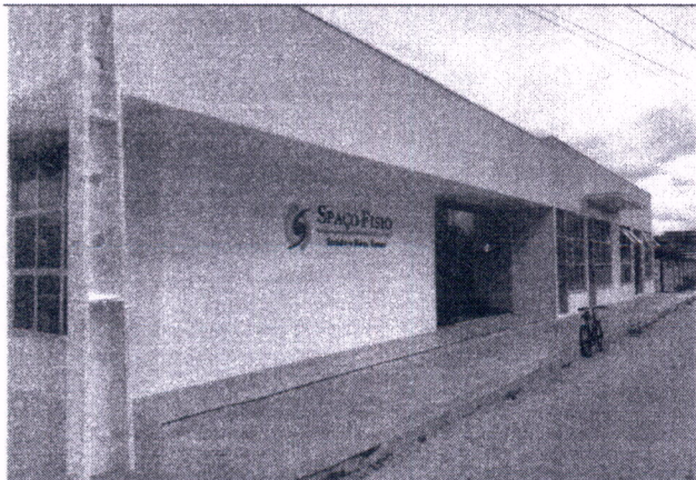
Descrição: EXECUÇÃO FACHADA CONFORME PROJETO E PLANILHA
