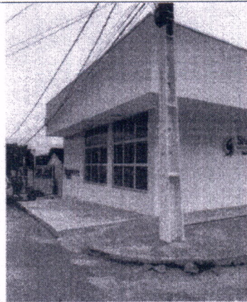
Descrição: EXECUÇÃO FACHADA CONFORME PROJETO E PLANILHA
